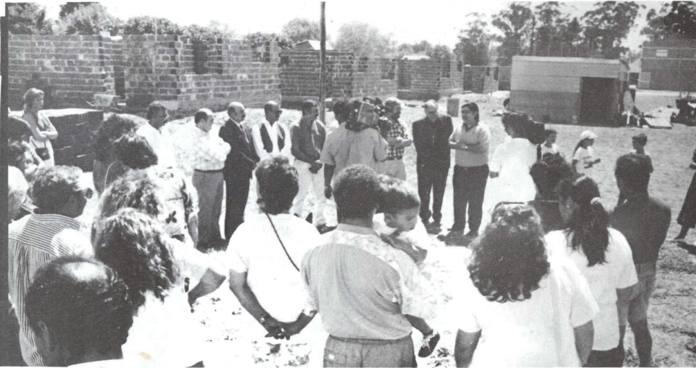
17/02/96 - Se inauguran oficialmente las obras del "Barrio Mugaburu". Habla el cto. José RIGANE.
