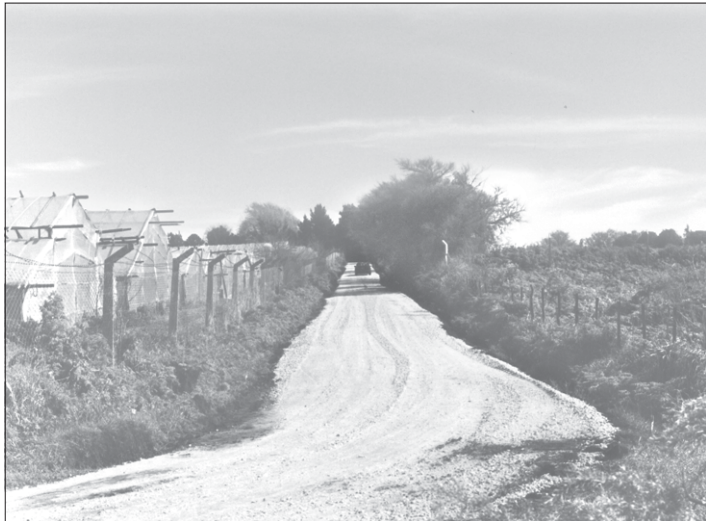
Motonivelado y engranzado de accesos, a cargo de personal de Vialidad municipal.
