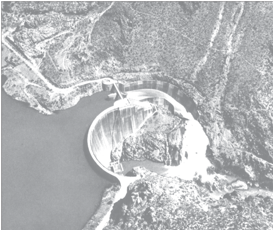
Presa La Angostura, en Sonora, México. Agua de riego e hidroelectricidad.
