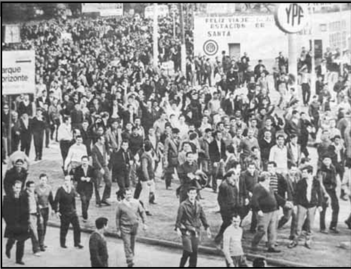
Trabajadores de Luz y Fuerza. El jueves 29 de mayo, por la mañana, las columnas obreras marcharon organizadamente hacia el centro de la capital cordobesa. Comenzaba a gestarse el Cordobazo.
